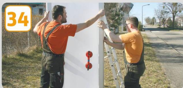
**34** Zum Zusammenbau das rechte Klapp-Profil in Grundprofil einrasten lassen
