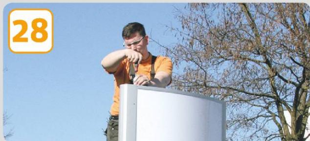
**28** Deckelschrauben entfernen
