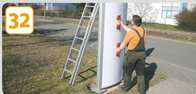
**32** Scheibe nach dem Lösen der Klapp-Profile nach vorn entnehmen
