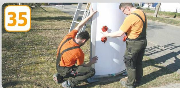
**35** Anschließend das linke Klapp-Profil durch Schläge mit der flachen Hand in Grundprofil einrasten lassen
